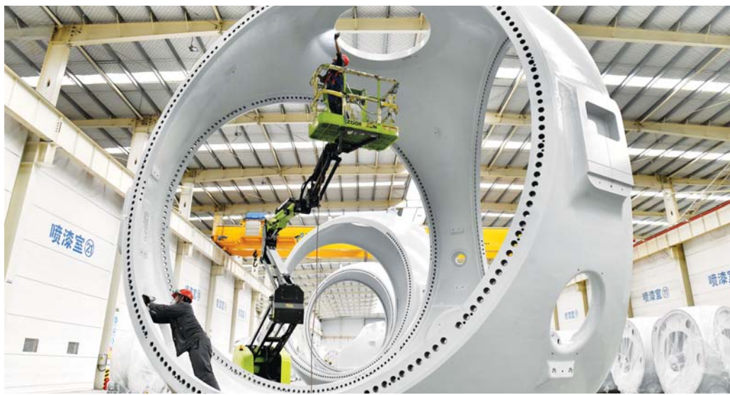
在山东省惠民县风电装备产业基地涂装车间，工作人员对风电轮毂进行涂装。
