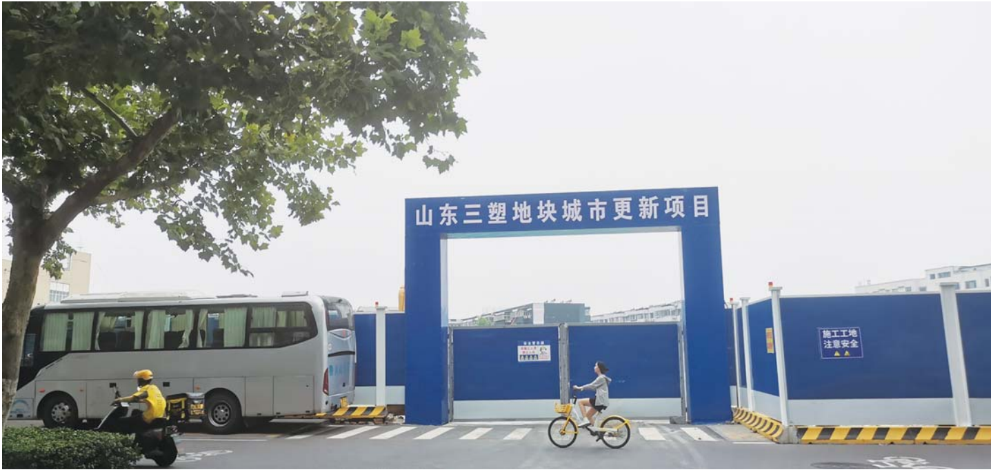
图为山东三塑地块城市更新项目的工地。 见习记者 于婉凝 摄
