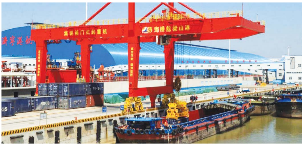
梁山港“公铁水”多式联运将京杭运河和瓦日铁路实现联通。
