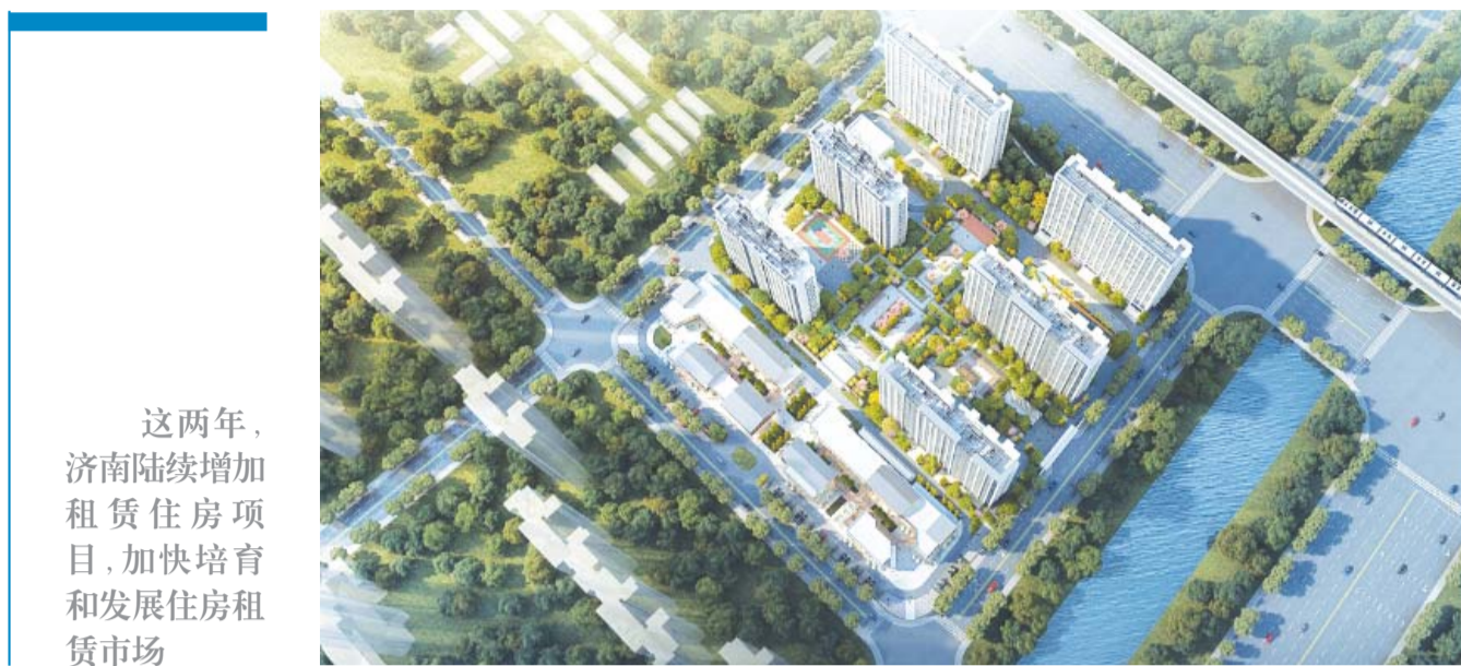
位于济南唐冶片区的租赁住房项目——彭家庄站地块项目鸟瞰图
