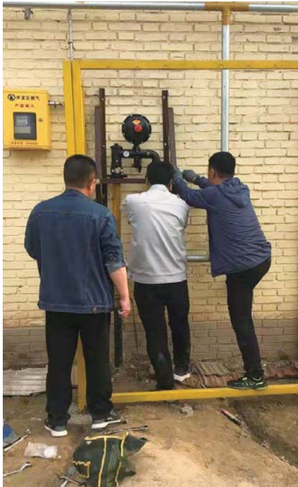
图为经开区燃气公司实施“气代煤”工程
