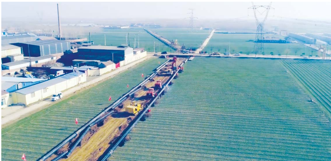
济南港华燃气“两环三线”建设，为泉城东拓北跨和先行区重大项目建设提供充足的“新动能”
