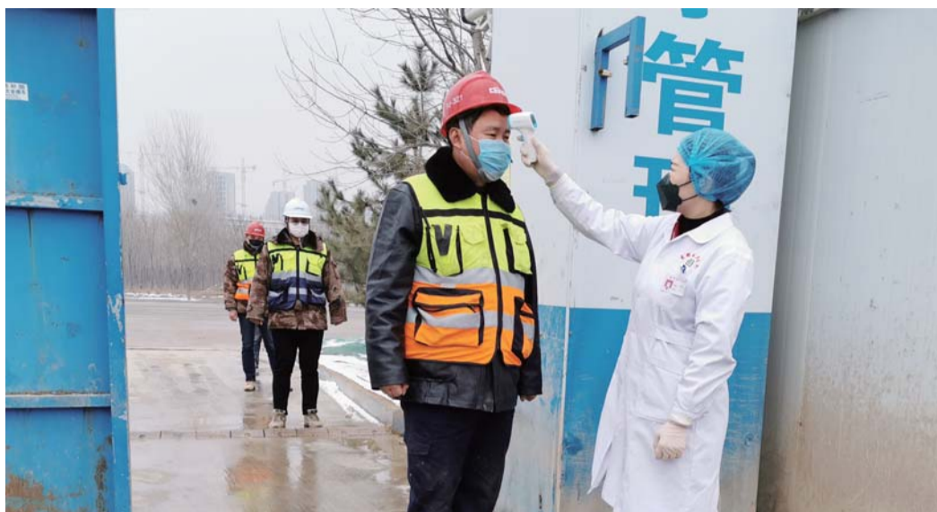
山东有研半导体大尺寸硅材料规模化生产项目建设现场，医务人员正在为建筑工人测量体温
