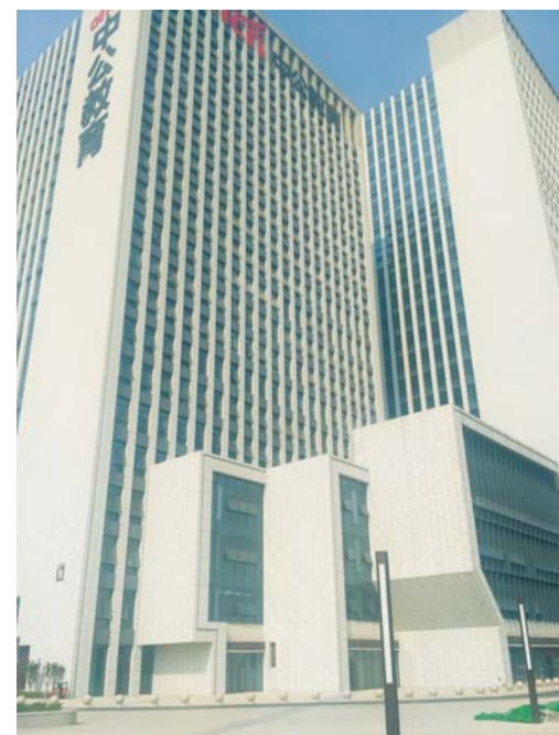
山钢新天地是济南为数不多的采用钢结构装配式建造的商业地产项目 杜杨 摄
