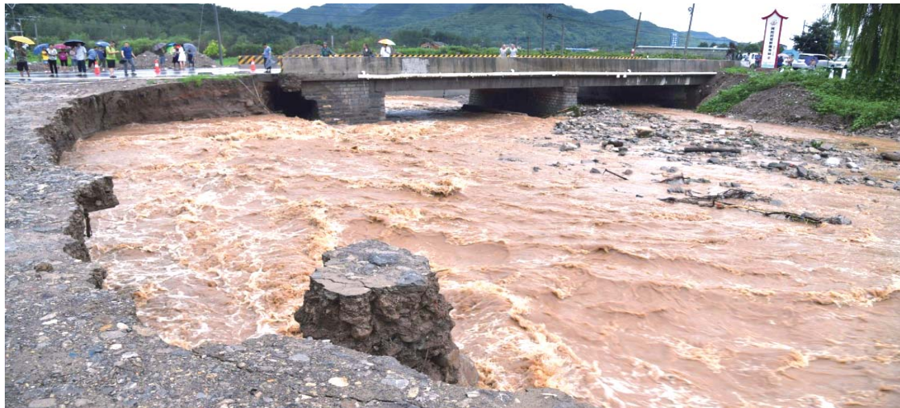
8月11日，在青州市王坟镇阿陀村，洪水已将河岸冲塌，危及桥梁
