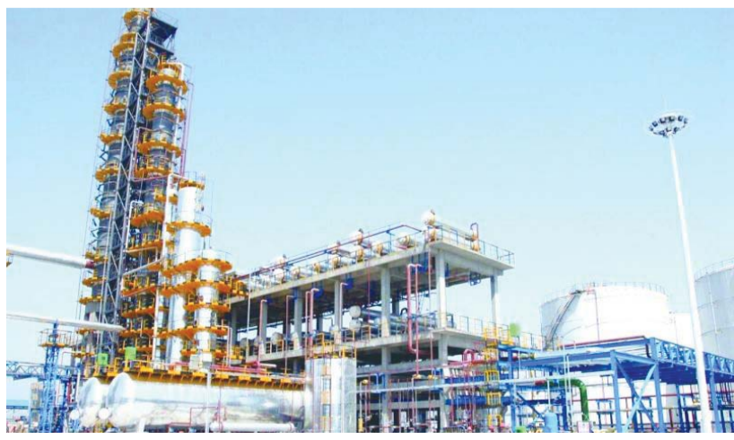
滨化股份厂区一角
