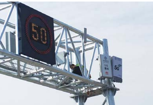
测试路段上部署的山东移动5G基站
