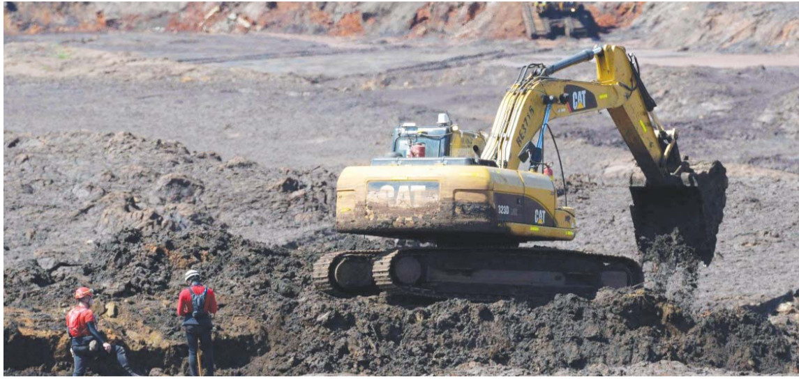
图为工人清理淡水河谷溃坝现场 据新华社
