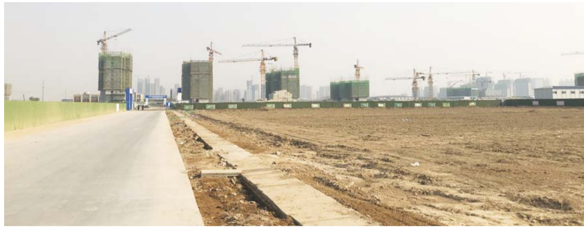
济南东站片区部分楼盘正在施工 王延锋 摄
