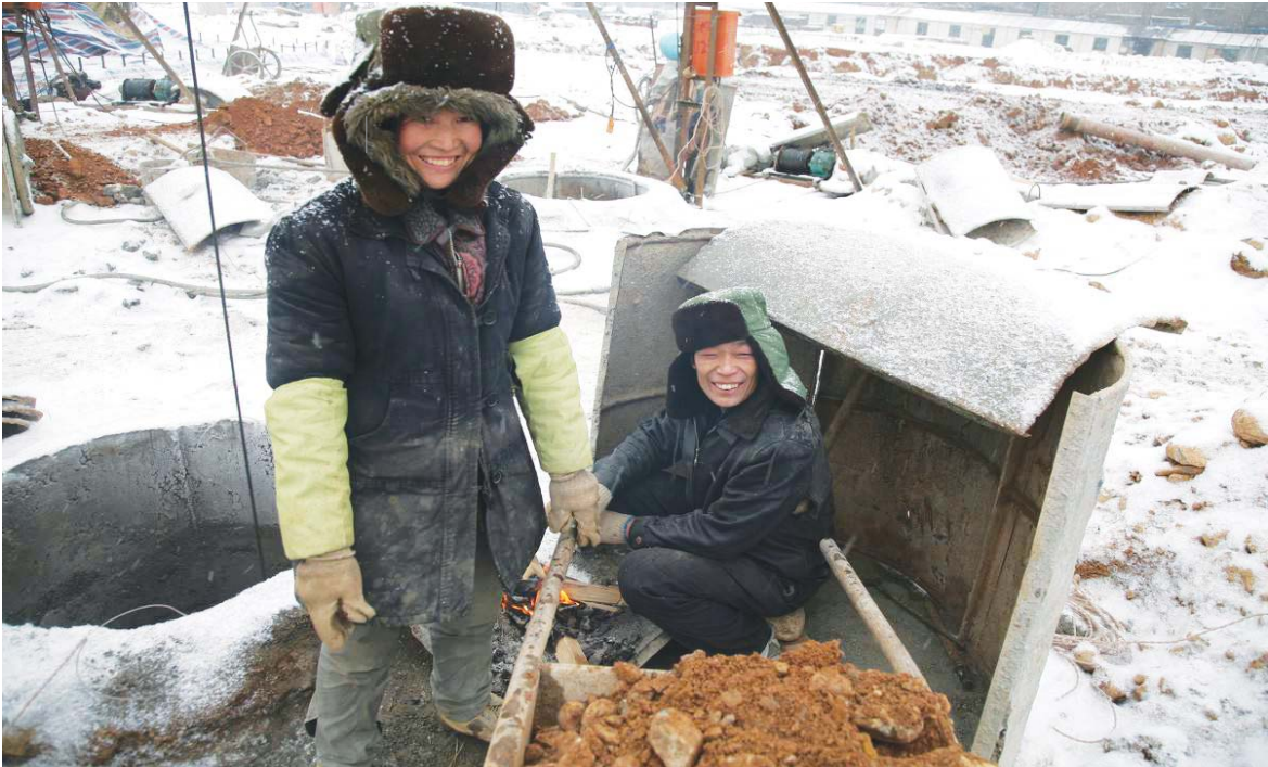
渣土可用于回填绿化,住房地下室、保护墙的建设及小型预制构件的制造都可以用建筑垃圾的再生品
